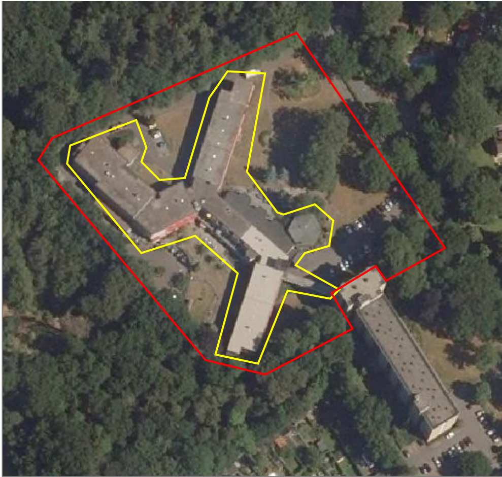
Figuur 2.3: Te slopen bebouwing binnen het plangebied (bron luchtfoto: ruimtelijkeplannen.nl).
