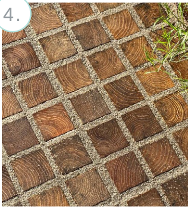
houten blokjes met een waterdoorlatende voeg
