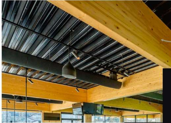
Geprofileerde staalplaten als plafond, kleur zwartgrijs RAL 7021. Houten constructie naturel behandeld
