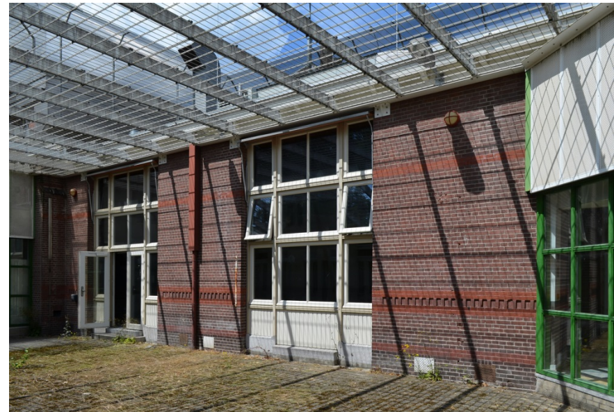
126. Oostelijke verbindingsvleugel, oostelijke gevel aan de zuidelijk luchtplaats vanuit het noordoosten, met links en rechts de gangen uit 1987-1989.
