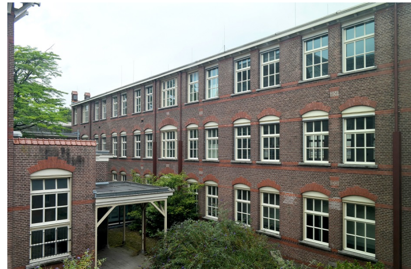
(Voormalige) Justitiële Jeugdinstelling Eikenstein, de centrale vleugel (voormalige chambrettesgebouw) aan de binnenplaats vanuit het zuidoosten, 2020 ( De Fabryck ).
