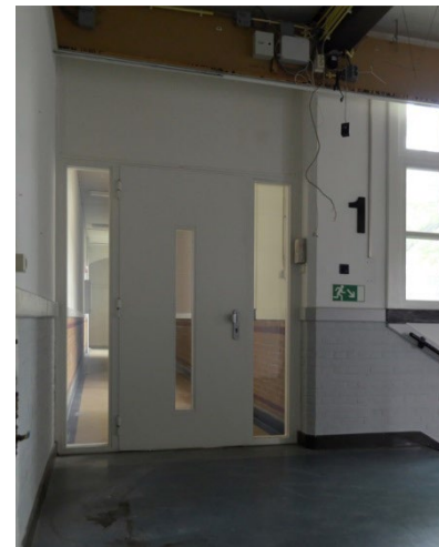
270. Zuidvleugel, eerste verdieping, westelijke zijvleugel, gang, het gestucte betonplafond met dito draagbalken (1904-1905), waarin een gat voor een koker is gezaagd.
