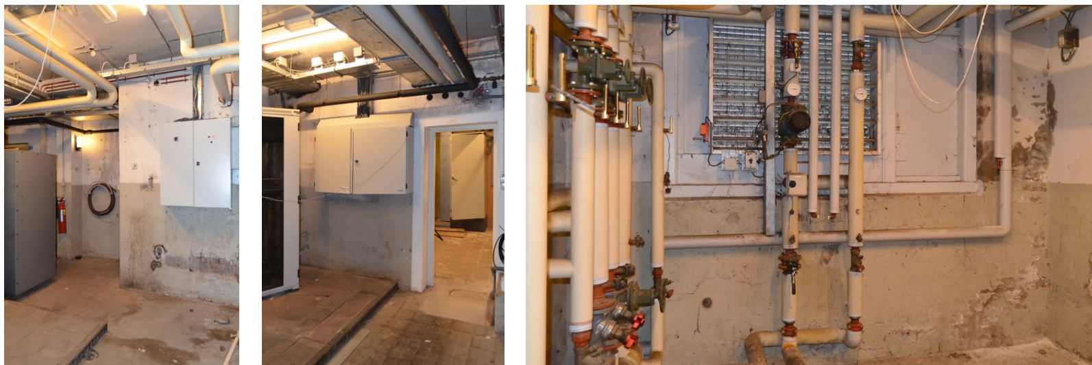
133. Zuidvleugel, kelder onder hoofdgebouw, oostelijke kelder vanuit het zuidoosten; achter de scheidingsmuur bevindt zich de trap.
