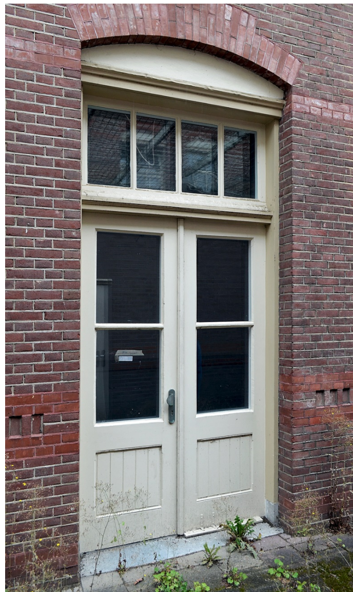
118. Noordvleugel, zuidgevel, centrale doorgang uit 1908-1909, voorzien van oorspronkelijk kozijn en een dito dubbele deur.
