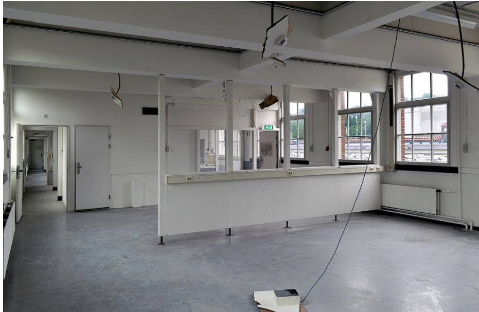
288. Centrale vleugel (of chambrettesgebouw), eerste verdieping, oostelijke recreatiezaal vanuit het zuidoosten met zijn zware gewapend-betonnen plafond/vloerconstructie.
