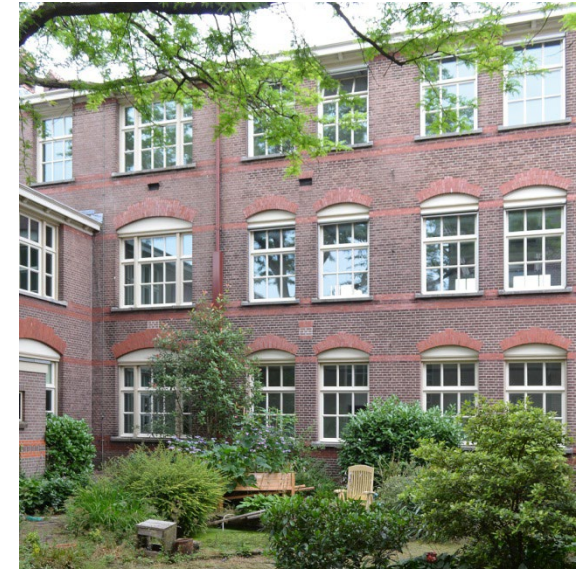
106. Centrale vleugel, westelijk deel van de zuidgevel aan de westelijke binnenplaats.
