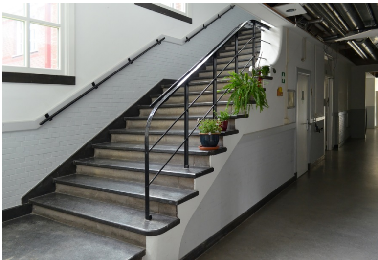
(Voormalige) Justitiële Jeugdinstelling Eikenstein, begane grond oostelijke zijvleugel, de oorspronkelijke trap van gewapend beton en Namense steen, 2020 (De Fabryck).
