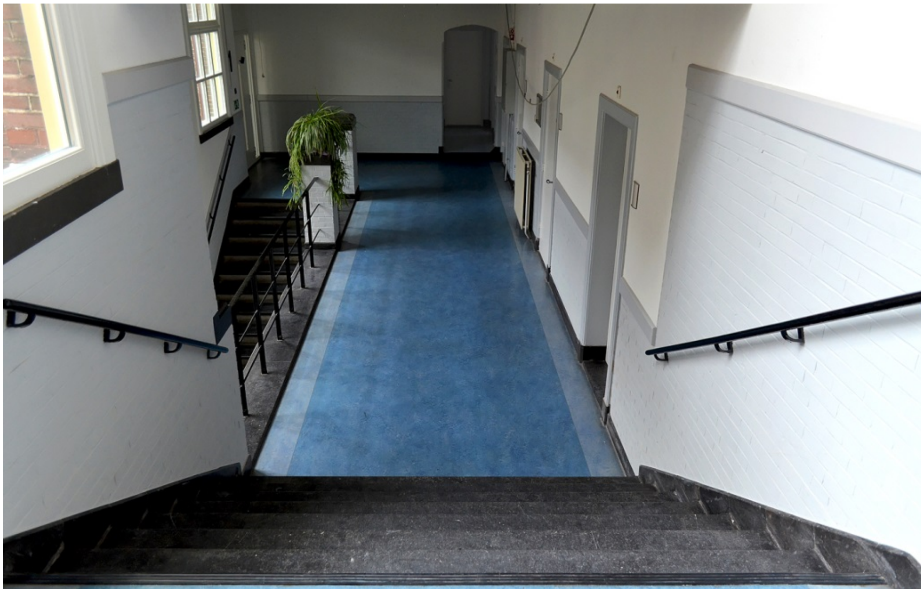
254. Zuidvleugel, eerste verdieping, oostelijke zijvleugel, gang vanuit het westen; de oorspronkelijke trappen zijn gemaakt van gewapend beton en Namense steen.
