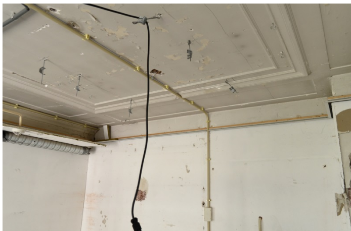
210. Noordvleugel, begane grond, oostelijke werkplaats, detail van het oorspronkelijke stucplafond, met zicht op het centrale perk met geprononceerde lijsten. 211. Noordvleugel, begane grond, oostelijke werkplaats, detail van het oorspronkelijke stucplafond, waarvan de randen een patroon van vlakke banden toont.
