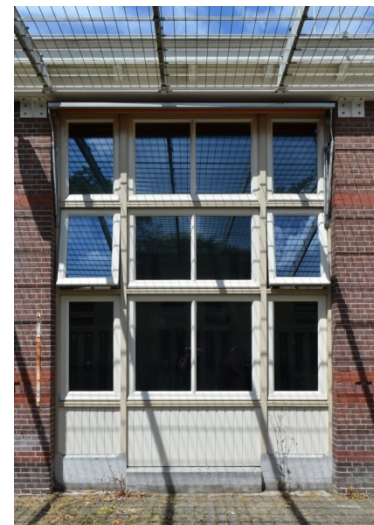
123. Oostelijke verbindingsvleugel, oostelijke gevel aan de zuidelijke lichtplaats, de zuidelijke pui met zijn oorspronkelijke kozijn, dat in de jaren 1960-1970 is voorzien van een extra tussendorpel (direct boven de dubbele deur) en schroten bij de borstwering, en na 2006 van zijn huidige historiserende ramen en dubbele deur. 124. Oostelijke verbindingsvleugel, oostelijke gevel aan de zuidelijke lichtplaats; de noordelijke pui heeft dezelfde geschiedenis, afgezien van de verwijdering van de dubbele deur in de jaren 1960-1970.
