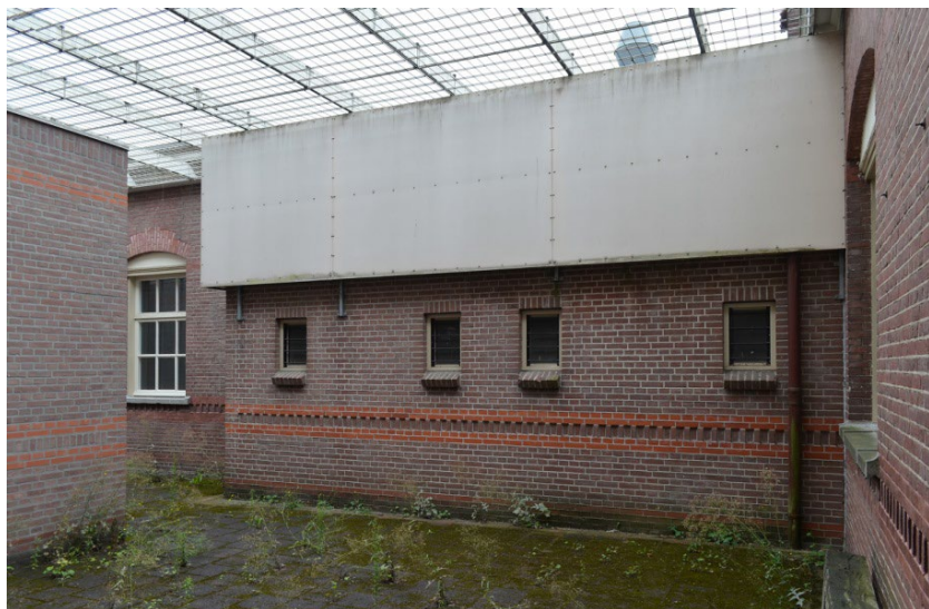
116. Noordvleugel, zuidgevel met in de noordoosthoek van de centrale luchtplaats een in 1980, vernieuwde aangebouwde toiletgroep.
