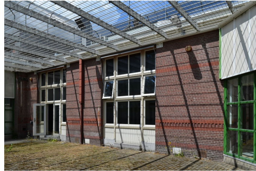
(Voormalige) Justitiële Jeugdinstelling Eikenstein, de oostgevel van de oostelijke verbindingsvleugel aan de zuidelijke lichtplaats, 2020 ( De Fabryck ).
