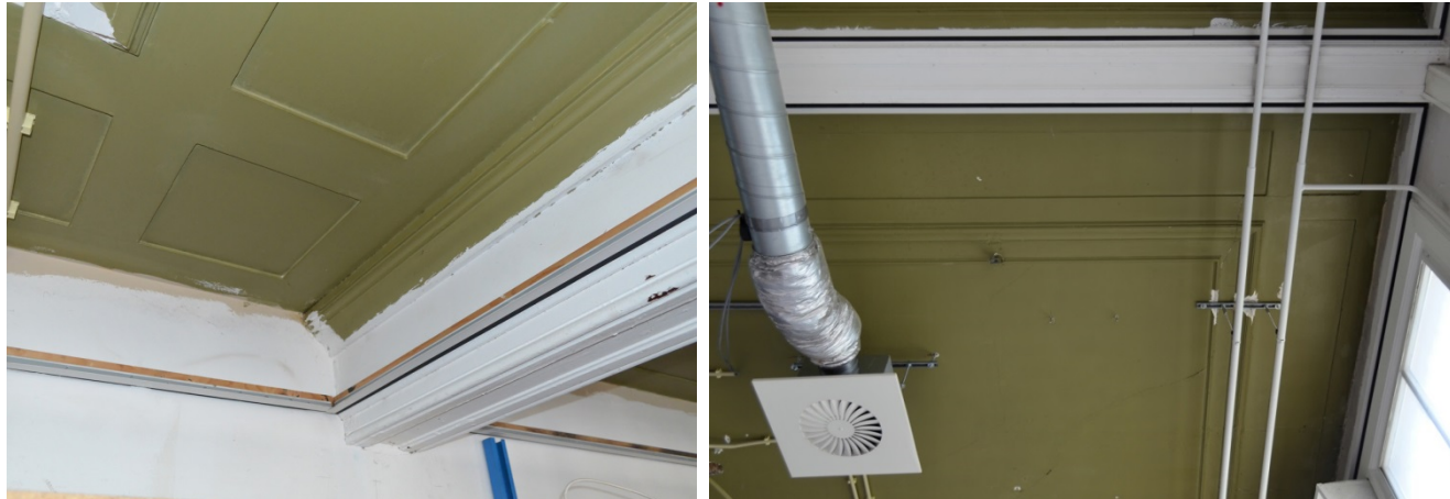
199. Noordvleugel, begane grond, westelijke werkplaats, detail van het oorspronkelijke stucplafond, waarvan de randen een patroon van vlakke banden toont. 200. Noordvleugel, begane grond, westelijke werkplaats, detail van het oorspronkelijke stucplafond, met zicht op het centrale perk van geprononceerde lijsten.
