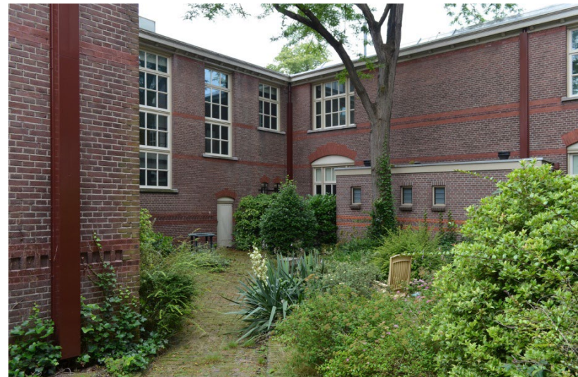
94. Zuidvleugel, achtergevel van de westelijke zijvleugel (links) en de oostgevel van de westelijke verbindingegang, met de in 1980 vernieuwde aangebouwde toiletgroep.
