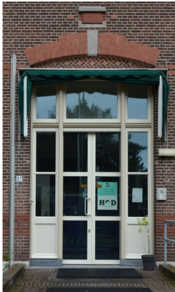
83. Zuidvleugel, hoofdgebouw, voorgevel, de hoofdingang, waarvan de pui dateert van 2006 en is gebaseerd op de oorspronkelijke pui uit 1904-1905.
