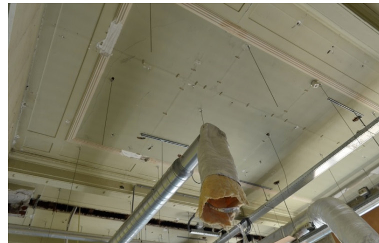
230. Oostelijke verbindingvleugel, begane grond, zuidelijke woonkamer (1904-1905), detail van de omtimmerde stalen onderslagbalk uit 1904-1905 (waaronder oorspronkelijk een houten wand stond) en een aantal balken van de dakconstructie (1904-1905).
