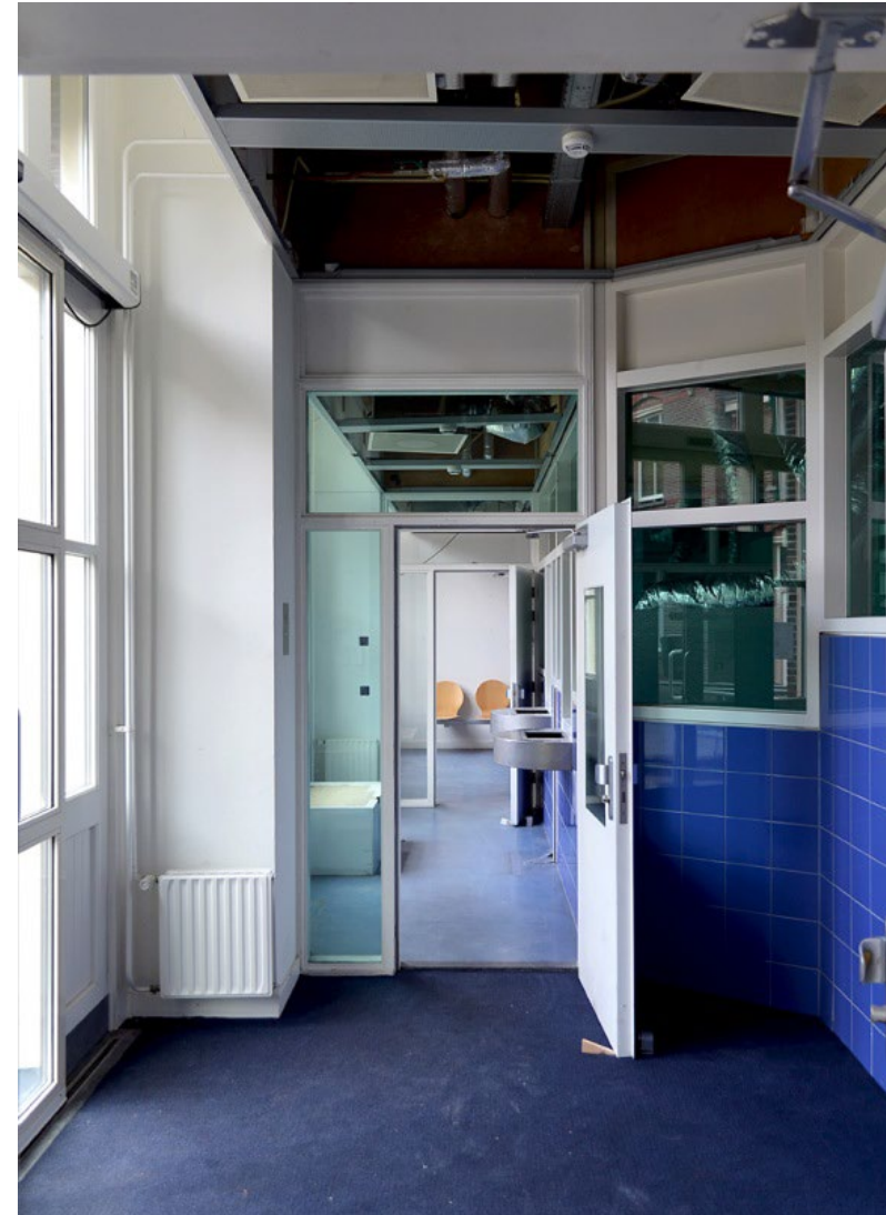
139. Zuidvleugel, begane grond, hoofdgebouw, entree vanuit het oosten met links de hoofdingang. De zuidbeuk is in 1998 geheel heringericht. Aan weerszijden van de entree bevindt zich een balie.
