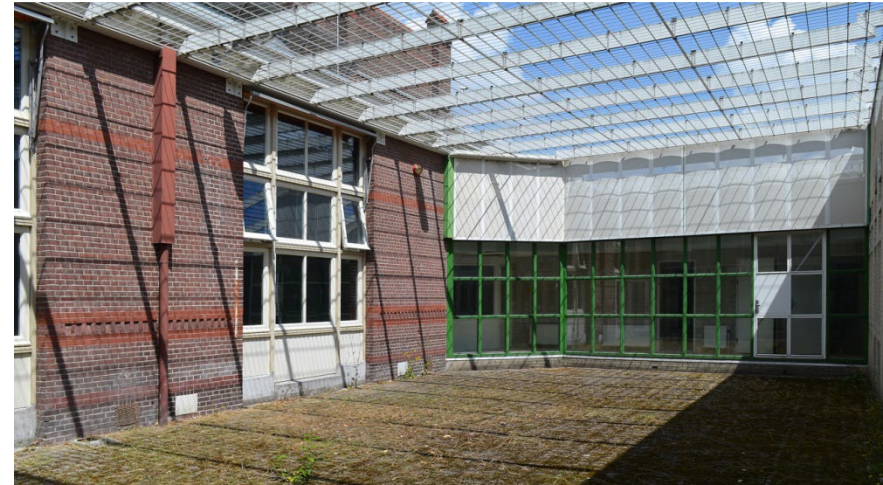
125. Oostelijke verbindingsvleugel, oostelijke gevel aan de zuidelijk luchtplaats vanuit het zuidoosten, met op de achtergrond de gang uit 1987-1989.
