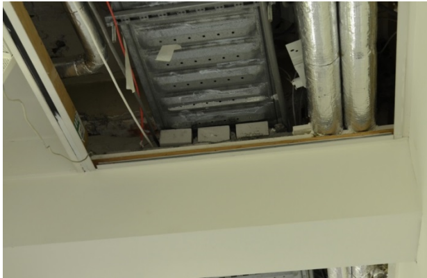
189. Centrale vleugel (of chambrettesgebouw), begane grond, gang, detail van het plafond met een van de omkokerde stalen balk met metselwerk uit de jaren 1987-1989 die de betonbalk uit 1904-1905 lijkt te vervangen.
