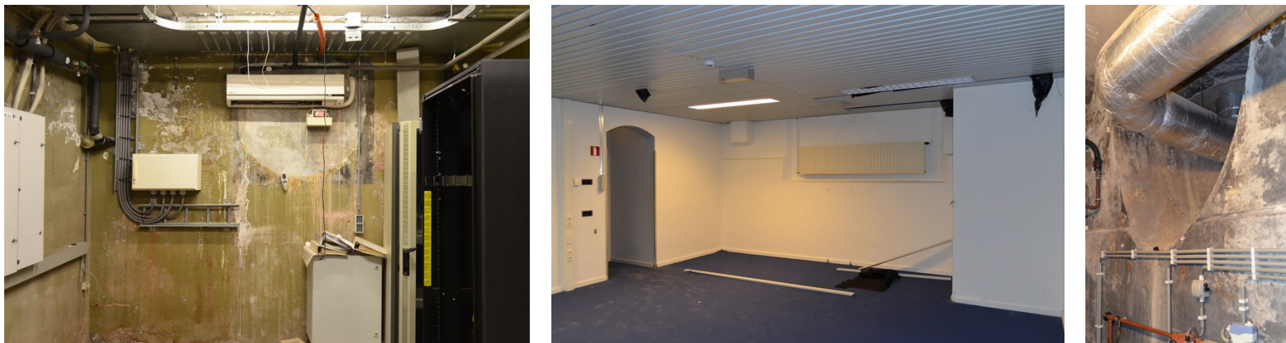
136. Zuidvleugel, kelder onder hoofdgebouw, westelijke kelder, zuidmuur met het gedichte stortgat voor kolen.
