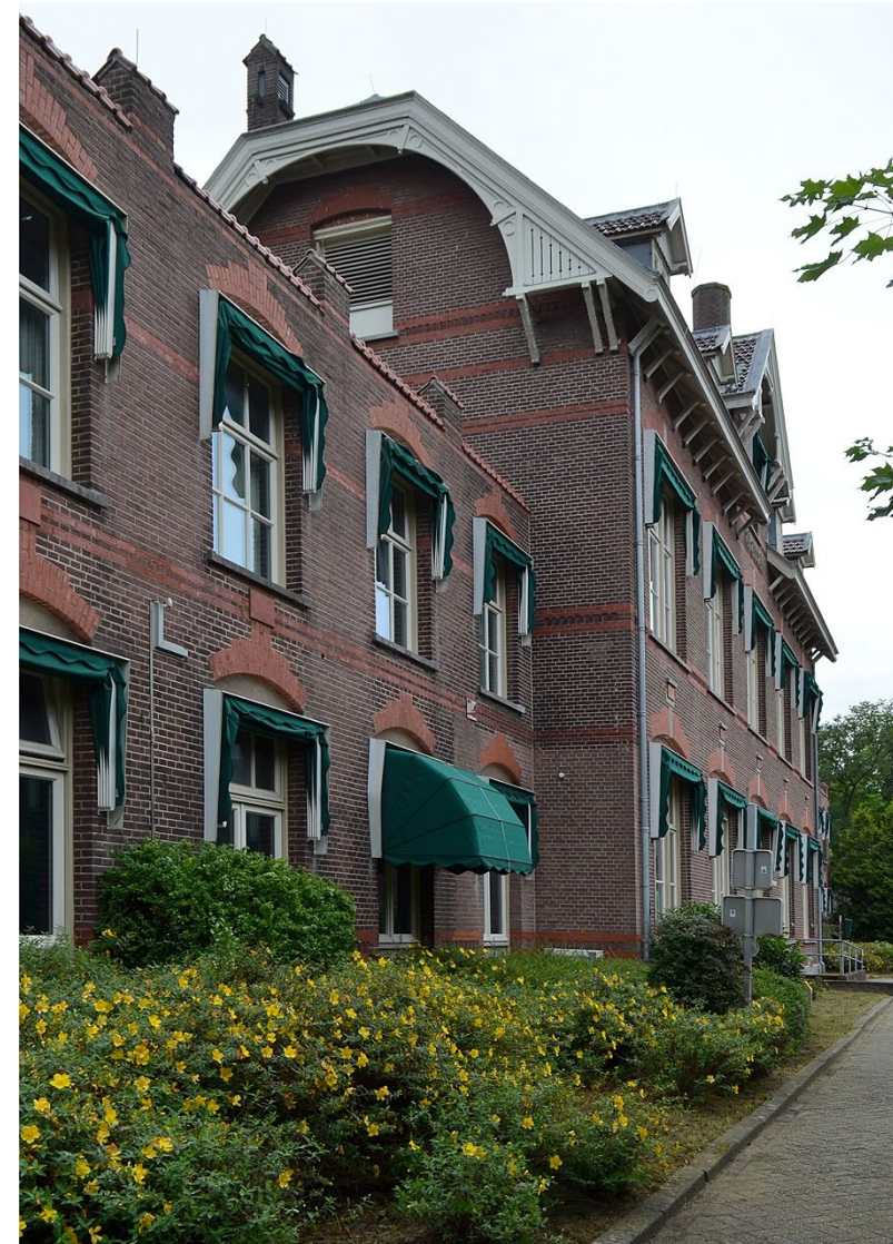
86. Zuidvleugel, zijvleugel en hoofdgebouw vanuit het westen met zicht op de westgevel van het hoofdgebouw, waarvan het raam in de top in 1990-1994 is vervangen door een luchtbehandelingsrooster.
