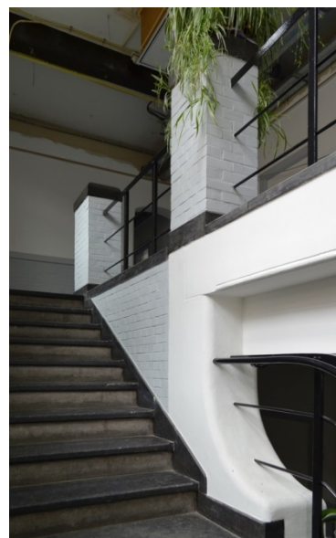
149. Zuidvleugel, begane grond, oostelijke zijvleugel, de trap van gewapend beton en Namense steen in het uitgebouwde trappenhuis uit 1904-1905, vanuit het zuidwesten.
