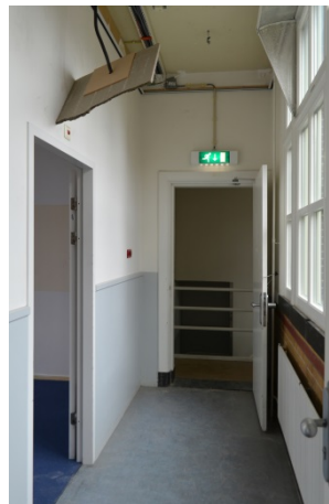
289. Centrale vleugel (of chambrettesgebouw), eerste verdieping, oostelijke lokaal vanuit het zuidwesten; de noordmuur (rechts) bezit nog de oorspronkelijke lambrisering, maar overschilderd in de jaren 1990-1994, evenals het oorspronkelijke venster waartegen na 2006 voorzetramen zijn aangebracht.
