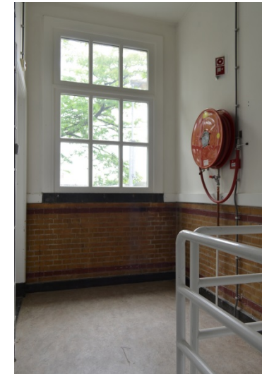
278. Westelijke verbindingsvleugel, eerste verdieping, trappenhuis vanuit het noordwesten; de trap uit 1908-1909 is in 1987-1989 door het huidige stalen exemplaar vervangen, dat toen ook is doorgetrokken naar de begane grond (inbouwen in de hoeken van de woonkamers).
