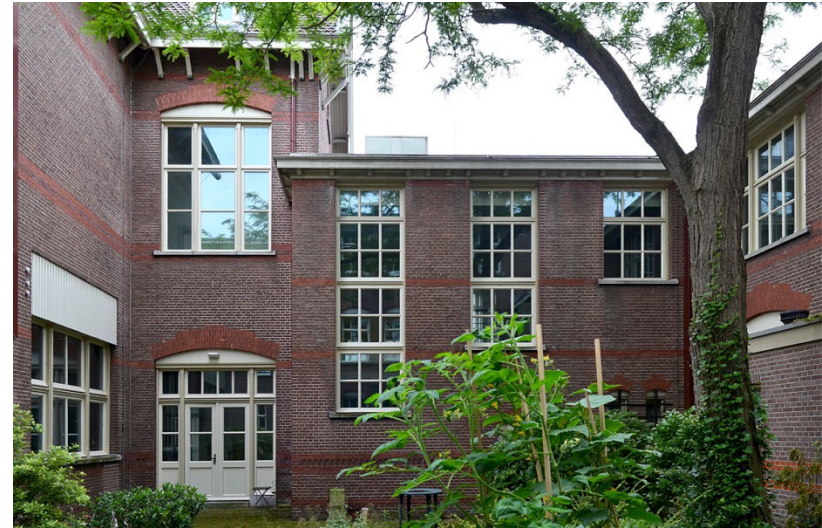
93. Zuidvleugel, achtergevel hoofdgebouw (links) en westelijke zijvleugel ofwel van het uitgebouwde trappenhuis (rechts) vanaf de westelijke binnenplaats.
