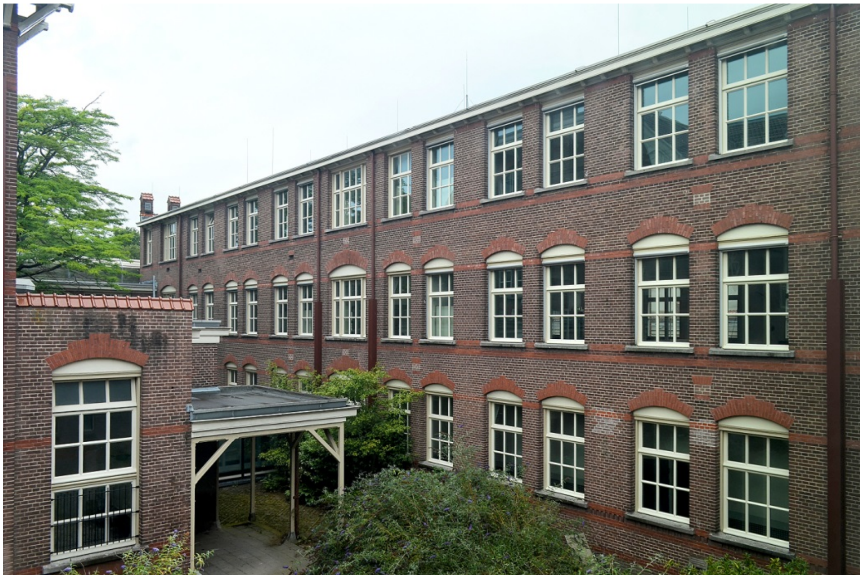
105. Centrale vleugel ofwel het voormalige chambrettesgebouw uit 1904-1909, zuidgevel aan de westelijke en oostelijke binnenplaats vanuit het zuidoosten; de bovenste (tweede) verdieping dateert van 1908-1909.
