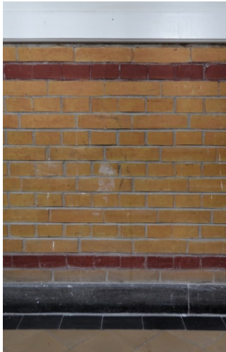
275. Westelijke verbindingsvleugel, eerste verdieping, gang, detail van de oorspronkelijke lambrisering (1904-1905) met zijn overschilderde houten lambriseringslijst.
