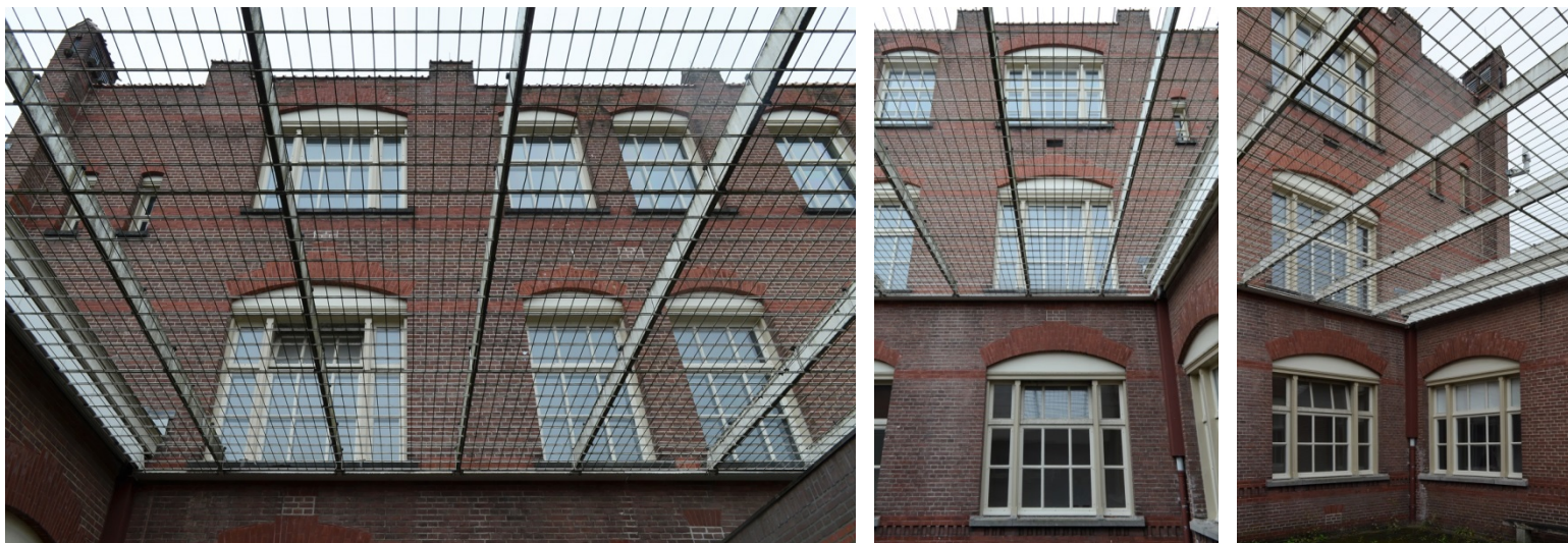
110. Centrale vleugel, noordgevel, verdiepingen, oostelijke deel.
