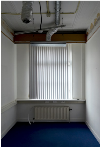
245. Zuidvleugel, eerste verdieping, oostelijke zijvleugel, kantoor 10 vanuit het noorden; de vensters in de zuidmuur van de zuidvleugel zijn allemaal oorspronkelijk, maar de ramen zijn na 2006 vernieuwd.
