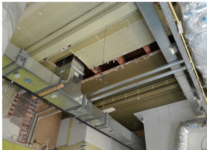
230. Oostelijke verbindingvleugel, begane grond, zuidelijke woonkamer (1904-1905), detail van de omtimmerde stalen onderslagbalk uit 1904-1905 (waaronder oorspronkelijk een houten wand stond) en een aantal balken van de dakconstructie (1904-1905).
