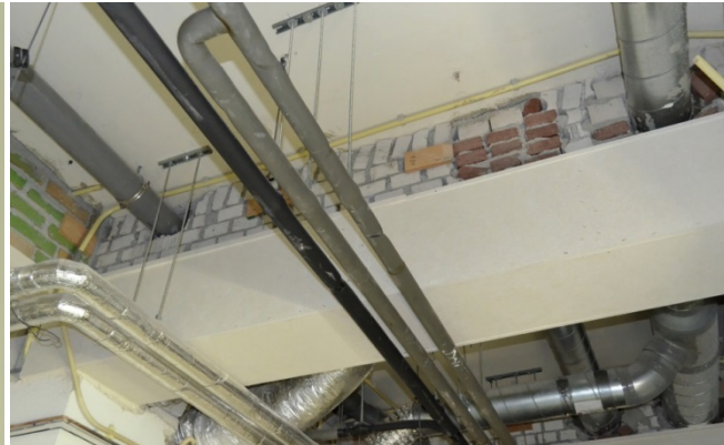
189. Centrale vleugel (of chambrettesgebouw), begane grond, gang, detail van het plafond met een van de omkokerde stalen balk met metselwerk uit de jaren 1987-1989 die de betonbalk uit 1904-1905 lijkt te vervangen.
