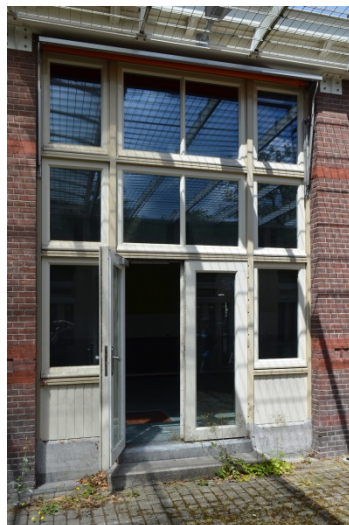
123. Oostelijke verbindingsvleugel, oostelijke gevel aan de zuidelijke lichtplaats, de zuidelijke pui met zijn oorspronkelijke kozijn, dat in de jaren 1960-1970 is voorzien van een extra tussendorpel (direct boven de dubbele deur) en schroten bij de borstwering, en na 2006 van zijn huidige historiserende ramen en dubbele deur. 124. Oostelijke verbindingsvleugel, oostelijke gevel aan de zuidelijke lichtplaats; de noordelijke pui heeft dezelfde geschiedenis, afgezien van de verwijdering van de dubbele deur in de jaren 1960-1970.
