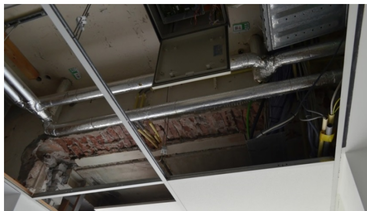
146. Zuidvleugel, begane grond, oostelijke zijvleugel, gang, sporen van de oorspronkelijke oostmuur, boven de doorbraak uit 1987-1989.
