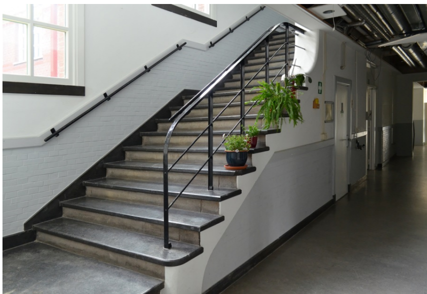
149. Zuidvleugel, begane grond, oostelijke zijvleugel, de trap van gewapend beton en Namense steen in het uitgebouwde trappenhuis uit 1904-1905, vanuit het zuidwesten.
