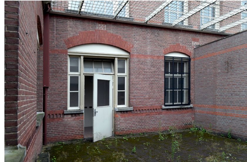
108. Centrale vleugel, noordgevel, begane grond, oostelijk deel van de centrale luchtplaats; de doorgang is in 1990-1994 aangebracht in een vensterpui.
