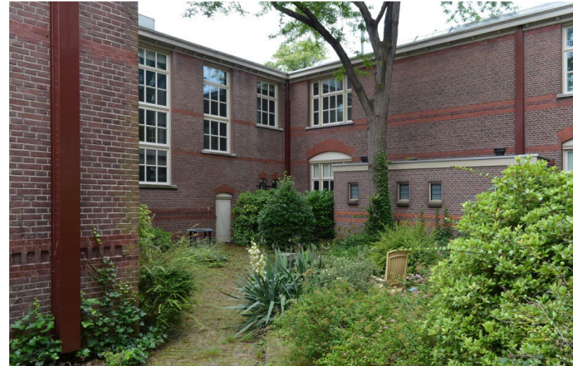
(Voormalige) Justitiële Jeugdinstelling Eikenstein, de zuidvleugel, achtergevel van de westelijke zijvleugel (links) en de oostgevel van de westelijke verbindingegang, met de in 1980 vernieuwde aangebouwde toiletgroep, 2020 ( De Fabryck ).
