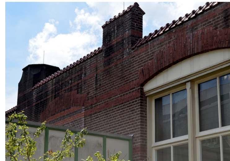
120. Noordvleugel, noordgevel, centrale deel waar in 1987-1989 een gang op is aangesloten, waarbij de bovenzijde van de oorspronkelijke doorgang is gedicht.
