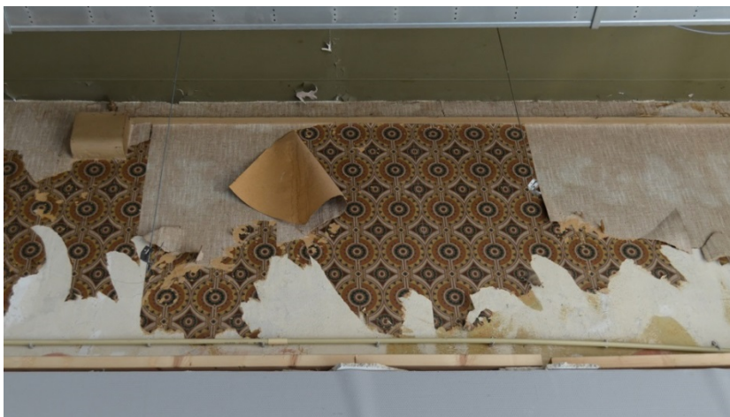
219. Oostelijke verbindingsvleugel, begane grond, noordelijke woonkamer (1908-1909), noordmuur; bovenaan bevinden zich restanten papierbehang die zijn aangebracht op de geschilderde stucclaa (1908-1909) en mede daarom lijken te dateren van de jaren 1920 of 1930.
