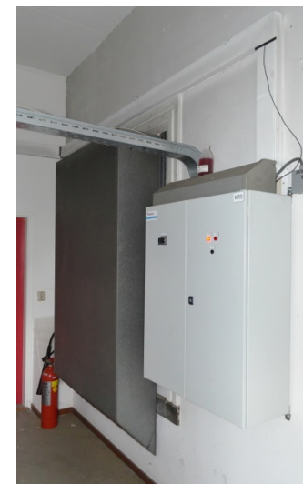
309. Zuidvleugel, tweede verdieping, hoofdgebouw, oostelijke technische ruimte, oostmuur, voor het venster is een luchtbehandelingskast aangebracht, waartoe het raam is vervangen door een rooster; dit is ook het geval bij de westmuur van de westelijke technische ruimte.
