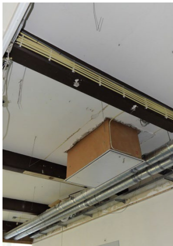
270. Zuidvleugel, eerste verdieping, westelijke zijvleugel, gang, het gestucte betonplafond met dito draagbalken (1904-1905), waarin een gat voor een koker is gezaagd.
