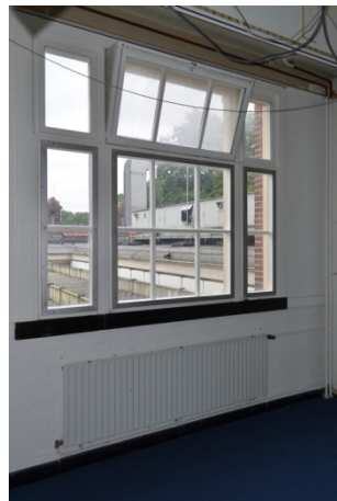
289. Centrale vleugel (of chambrettesgebouw), eerste verdieping, oostelijke lokaal vanuit het zuidwesten; de noordmuur (rechts) bezit nog de oorspronkelijke lambrisering, maar overschilderd in de jaren 1990-1994, evenals het oorspronkelijke venster waartegen na 2006 voorzetramen zijn aangebracht.
