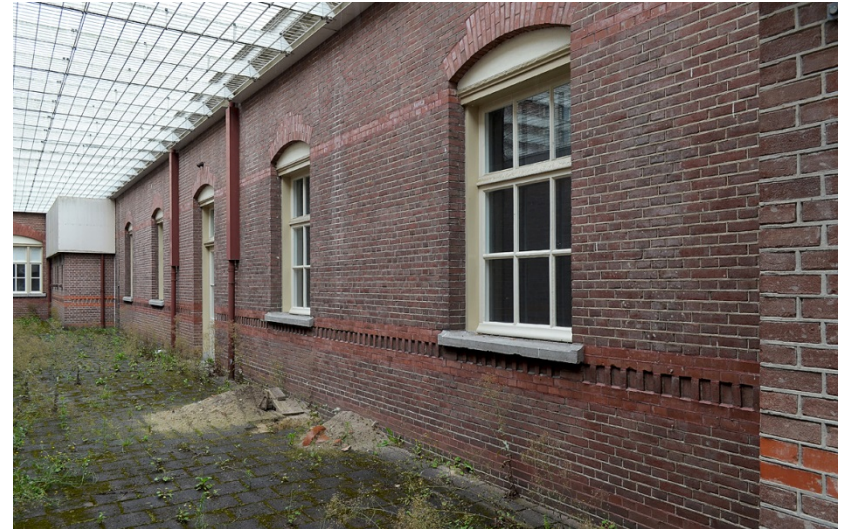
(Voormalige) Justitiële Jeugdinrichting Eikenstein, de zuidgevel van de noordvleugel, aan de centrale luchtplaats, 2020 ( De Fabryck ).
