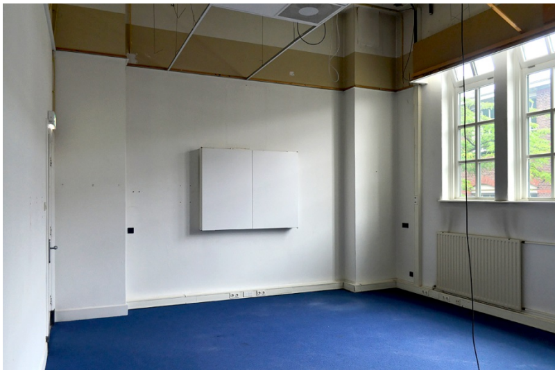
266. Zuidvleugel, eerste verdieping, hoofdgebouw, vm. kerk vanuit het zuidoosten, met in de hoeken bakstenen ventilatieschachten uit de bouwtijd.
