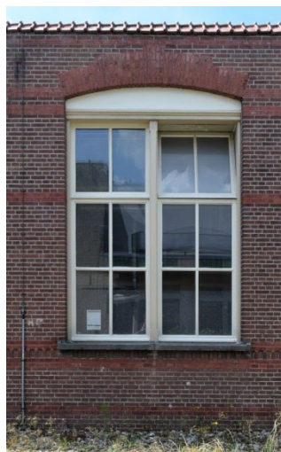
121. Noordvleugel, noordgevel, westzijde van de achtergevel vanuit het noordoosten; de vensters bezitten nog hun volledig oorspronkelijke vensterpuien. 122. Noordvleugel, noordgevel, één van de oorspronkelijke vensters uit 1908-1909.
