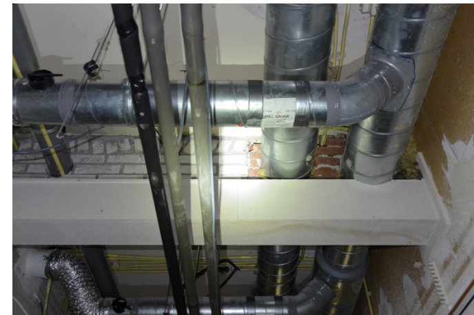
50. Zeist, (vm.) Justitiële Jeugdinstelling Eikenstein, centrale vleugel of voormalige chambrettesgebouw, begane grond vanuit het oosten, met de isoleercellen en de omkokerde stalen balken met metselwerk uit de jaren 1990 die de betonbalken uit 1904-1905 vervangen, waarvan onder een detail, 2020 ( De Fabryck ).
