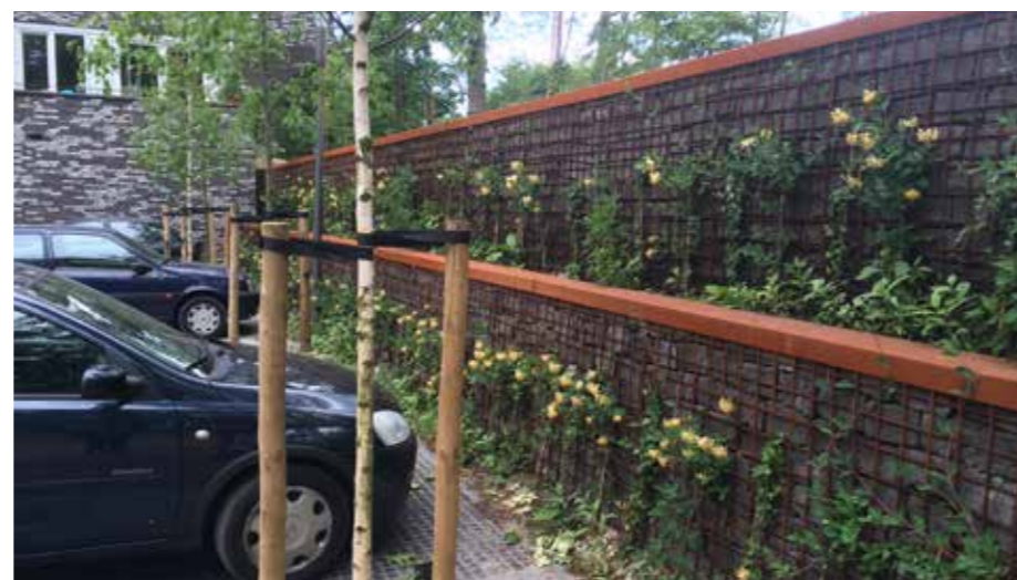
GETRAPTE KEERCONSTRUCTIE MET TURFBLOKKEN
