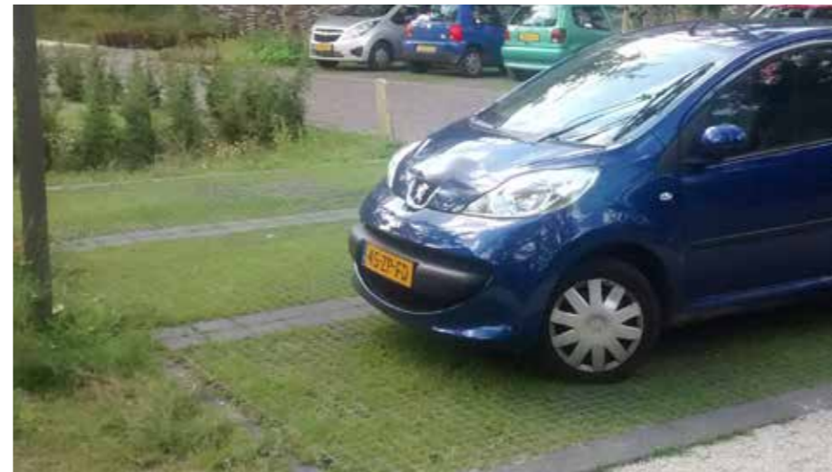
PARKEREN OP GRASBETONSTENEN
