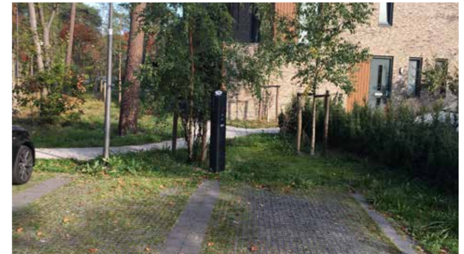
PARKEERPLAATSEN MET ELEKTRISCHE LAADPAAL
