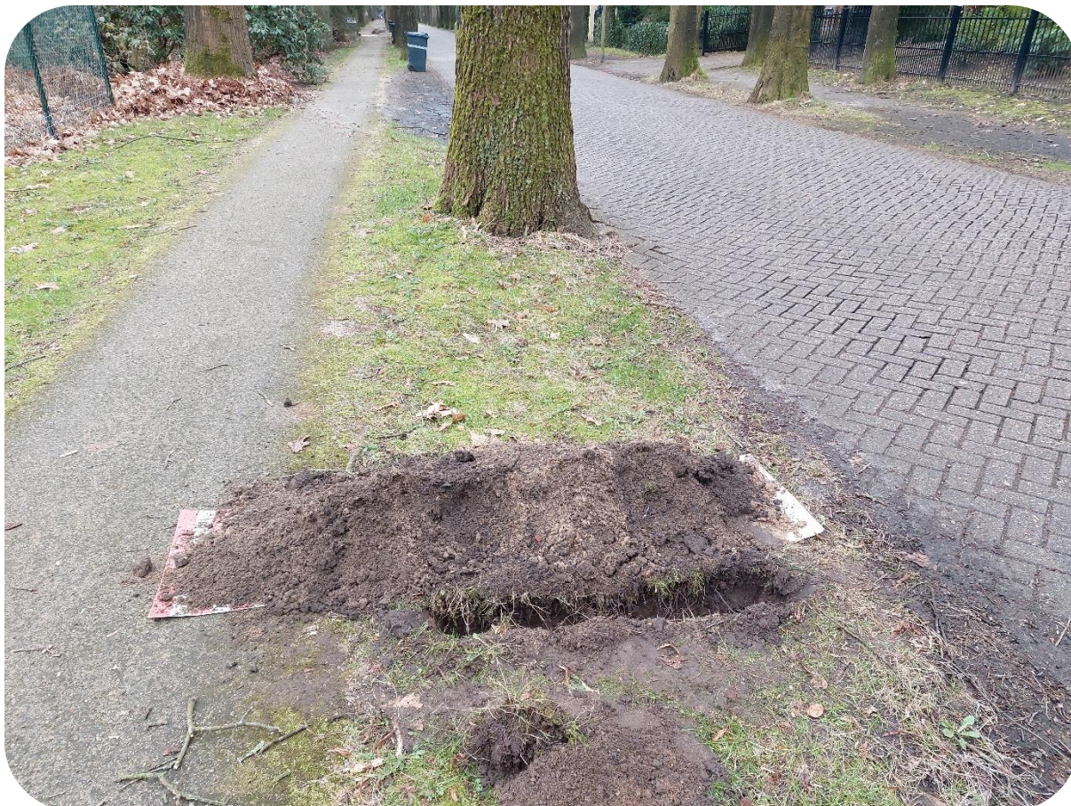
Foto 26: proefsleuf 7, nabij boom nummer 43, op circa 3 meter uit de boom
