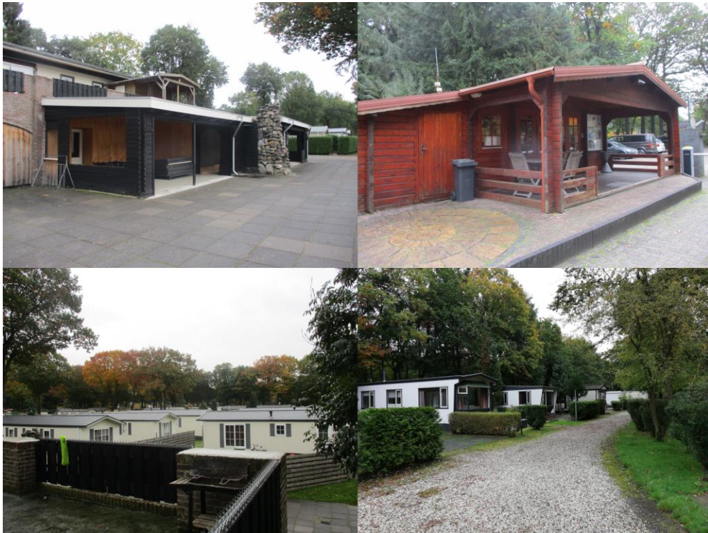
Figuur 1 Het recreatiepark met vakantiehuisje, stacaravans, de receptie en het bijgebouw (A).
