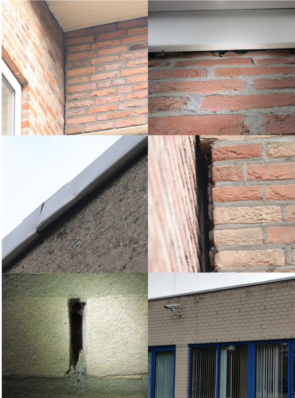
Figuur 6 Kieren, open stootvoegen, kierende daklijsten en boeiboorden kunnen geschikte rust- en verblijfplaatsen zijn voor gebouwbewonende vleermuizen.
