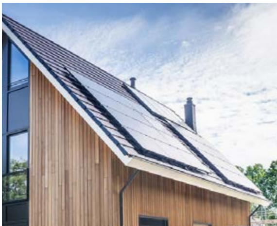
PV panelen integreren of op vlakke pannen
