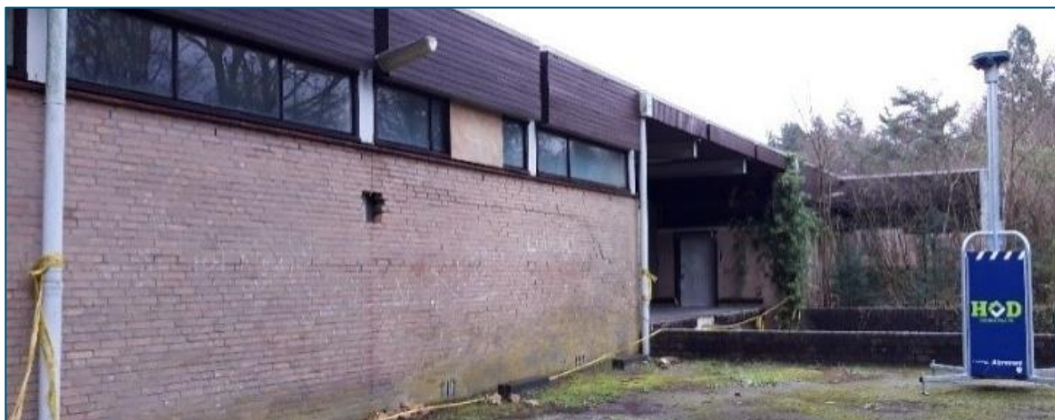
Figuur 4-2: overzichtsfoto van het gebouw 20 (Centrale Keuken). Foto: Royal HaskoningDHV, 2020.
