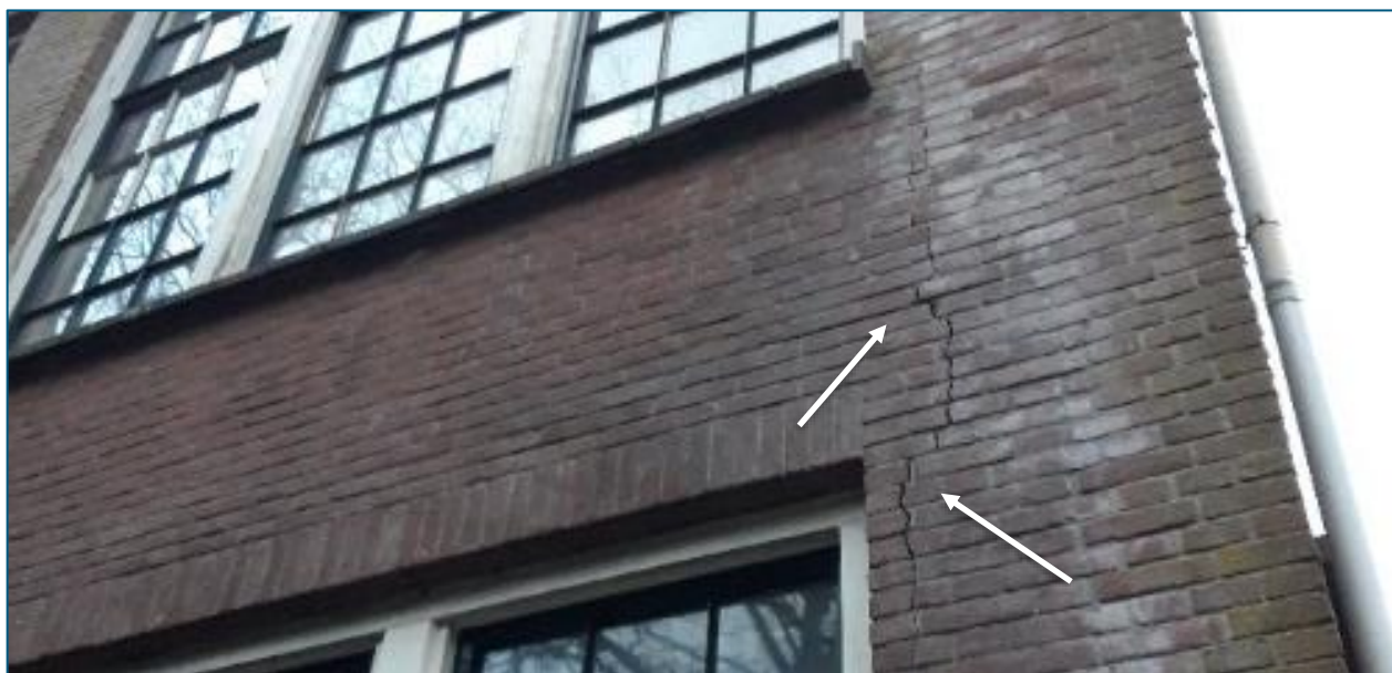
Figuur 4-5: detailfoto van de achtergevel van gebouw 24 (Bedrijfsgebouw). Foto: Royal HaskoningDHV, 2020.
