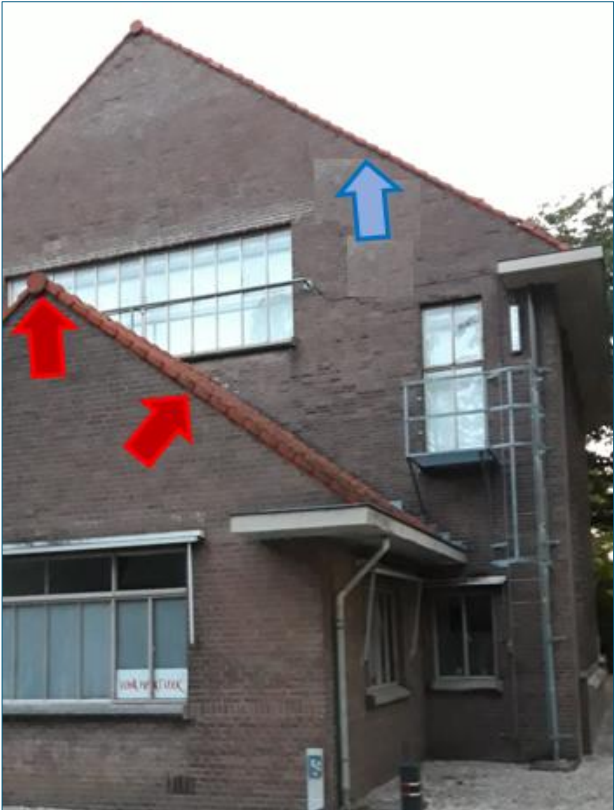
Figuur 5-2: de rode pijlen zijn de zomerverblijfplaatsen van twee gewone dwergvleermuizen in het deel van gebouw 27 (Hoofgebouw) dat wordt gesloopt, de blauwe pijl is een locatie van een zomerverblijfplaats dat intact blijft. Foto: Royal HaskoningDHV, 2020.
