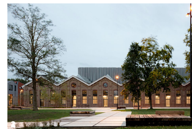
4 Parkeergebouwen verbergen zich achter de historische en kleinschalige gebouwen
