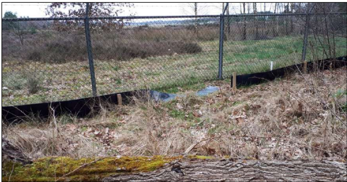
Figuur 4.4 Schade aan het reptielenscherm. Bron foto: Ecogroen.
