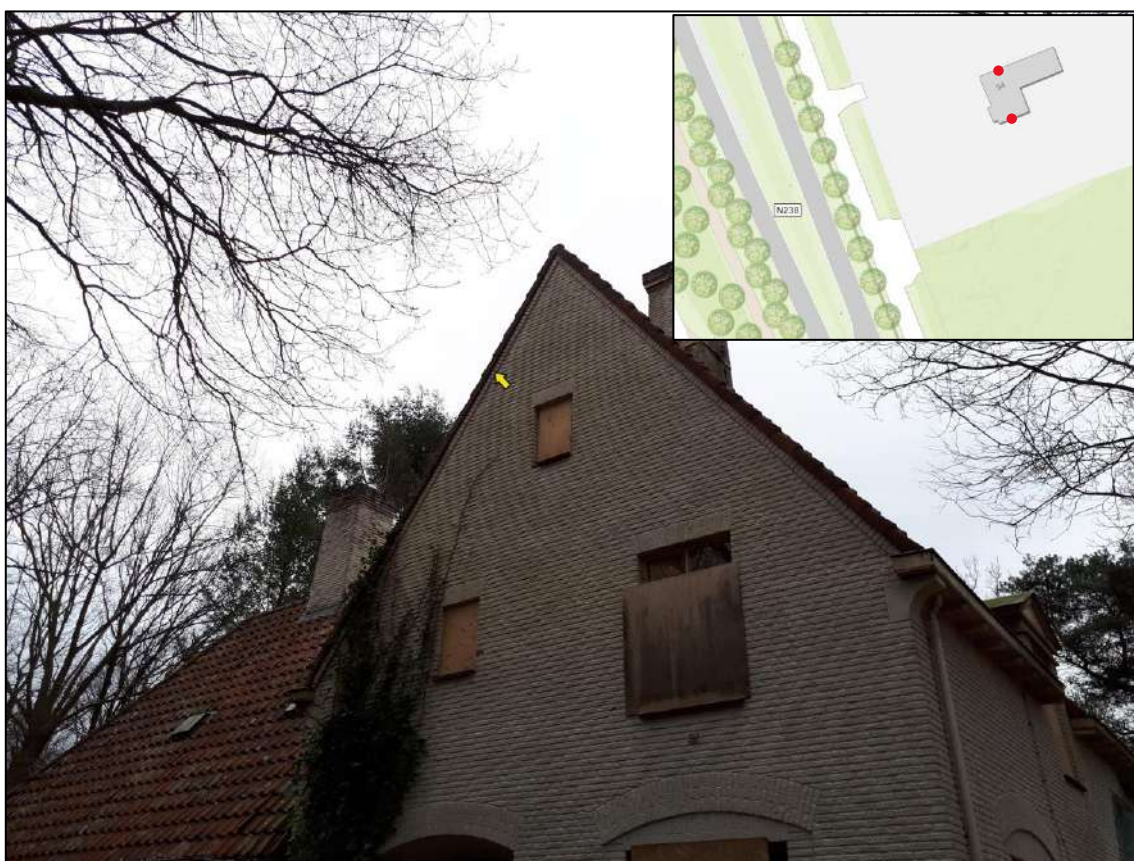
Figuur 4.3 Invlieglocatie (gele pijl) onder de kopgevelpannen aan de noordzijde van het gebouw en uitsnede van topografische kaart met locaties van de zomerverblijfplaatsen (rode stippen). Bron topografische kaart: ESRI.
