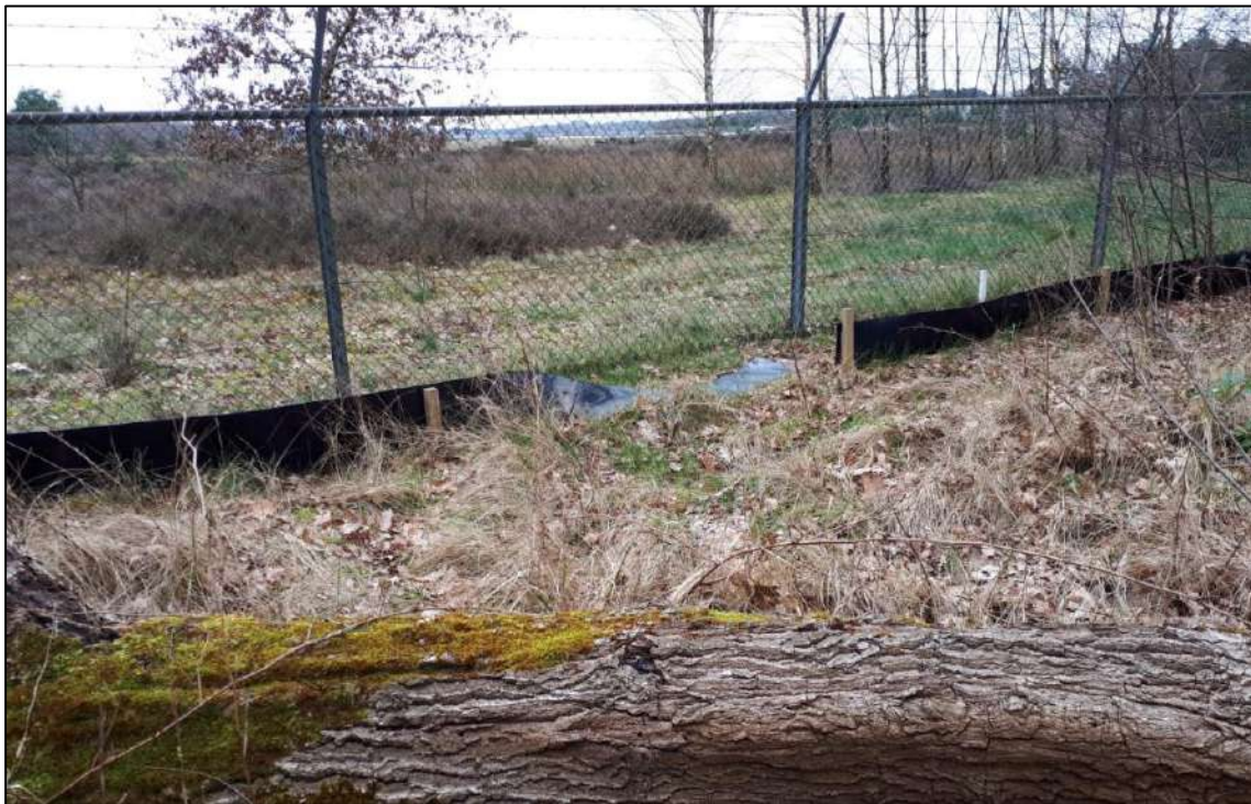
Figuur 4.5: Schade aan het reptielenscherm Foto: Arjan van Vuuren, Ecogroen.
