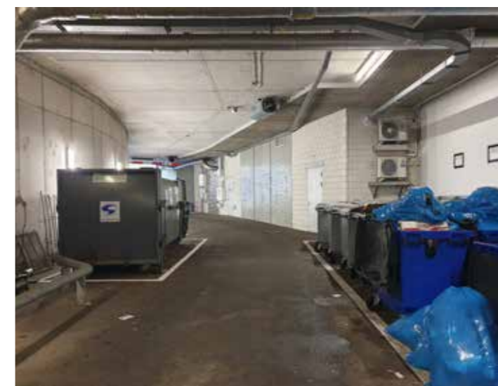
De logistieke doorgang naast de parkeergarage
