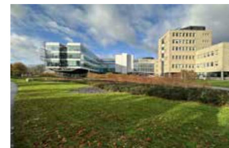
Het gebouw vanaf fietspad westzijde
